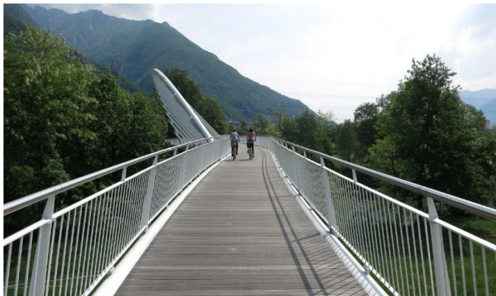
Ponte ciclopedonale di Monte Carasso – Bellinzona (TI)
